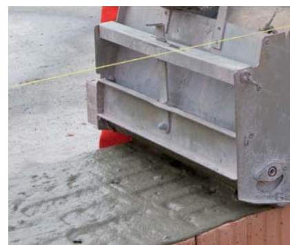
celoplošné nanášení vozíkem
