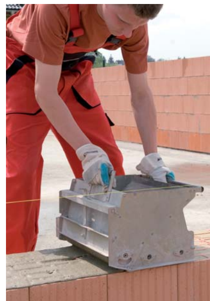
celoplošné nanášení vozíkem
