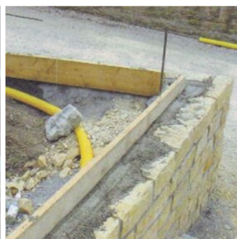
Obr.2 Nanášení zdicí malty na zdivo.
