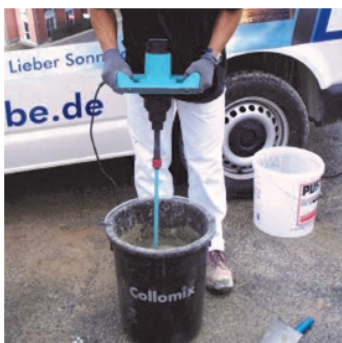
Obr.1 Namíchání malty pomocí elektrického míchadla.
