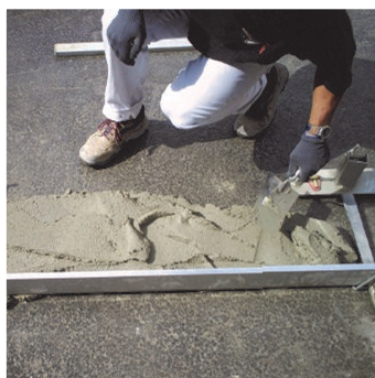
Obr.3 Rozhrnutí malty na podkladu mezi zakládací soupravu.
