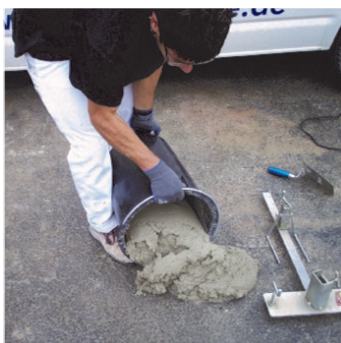
Obr.2 Nanesení malty na podklad do zakládací soupravy, začíná se od nejvyššího bodu základové desky.
