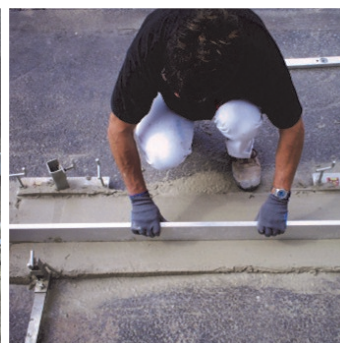
Obr.4 Urovnání zakládací malty pomocí zakládací soupravy.
