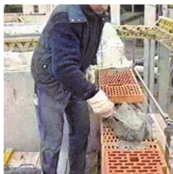
Obr.2 Nanášení zdicí malty na zdivo.
