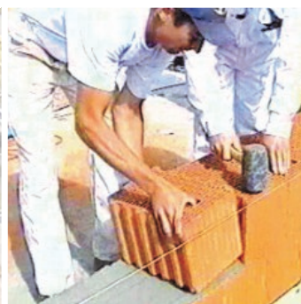
Obr.3 Pokládání cihelných bloků.
