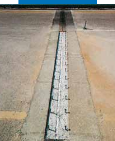
Oprava dilatační spáry dálničního mostu Mapefillem
