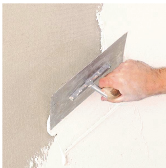
Obr.3 Nebo nanášení tenké vrstvy jako štukové omítky.
