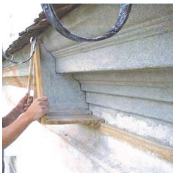
Obr.2 Tažení malty ve tvaru profilu.
