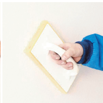
Obr.4 Filcování povrchu.
