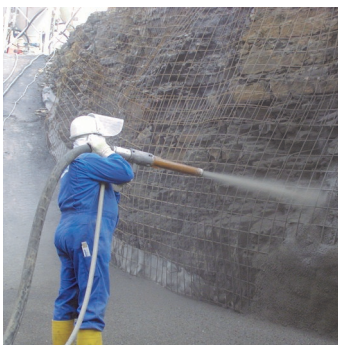
Obr.3 Nástřik betonu na podklad.
