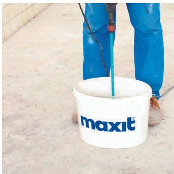
Obr.2 Namíchání stěrky pomaluběžným míchadlem.
