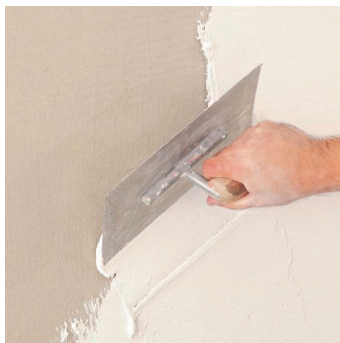
Obr.3 Nanášení stěrky nerezovým hladítkem.
