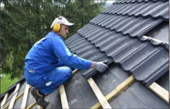
Pokládá se od hřebene k okapu
