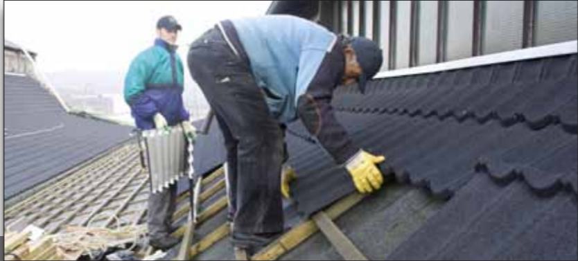
Krytina Isola Powertekk může být položena přímo na starou krytinu
