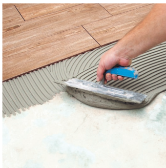
Obr.3 Nanášení lepidla na podklad.
