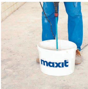
Obr.2 Namíchání lepidla míchadlem.
