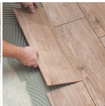
Obr.3 Lepení obkladů nebo dlažby.
