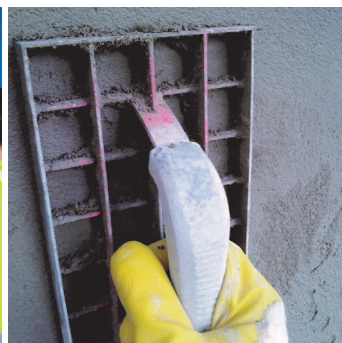
Obr.4 Následující den strhnout povrch škrábákem.
