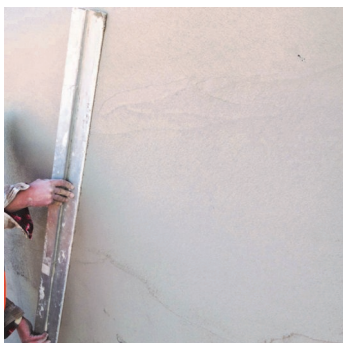
Obr.2 Urovnání povrchu "h-latí".
