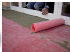
Do vrstvy lepidla pokládáme s přesahem 10 cm
