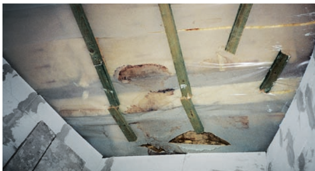
Poškození způsobené zkondenzovanou vodou
