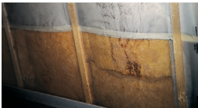
Poškození způsobené zabudováním vlhkého dřeva
