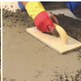
Obr.4 Vyhlazení povrchu a vhodné ošetřování.
