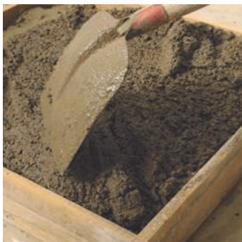
Obr.2 Nasypání do bednění.
