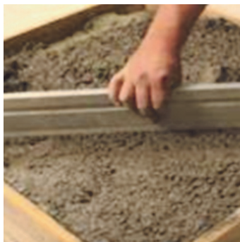
Obr.3 Urovnání a zhutnění betonu.
