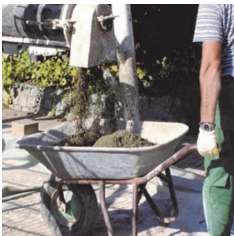
Obr.1 Namíchání kontinuální míchačkou, bubnovou míchačkou nebo v kolečku.
